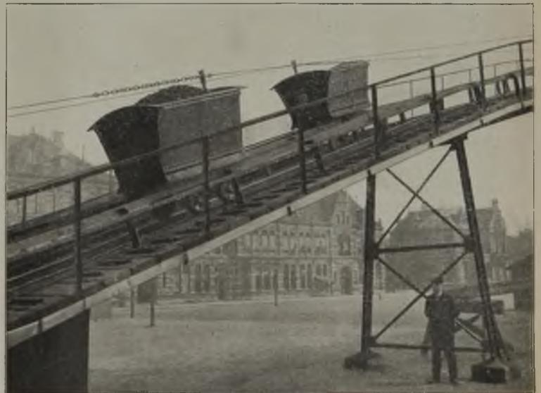
Abb. 15. Kettenseil-Gabelförderung mit 23° Steigung.
