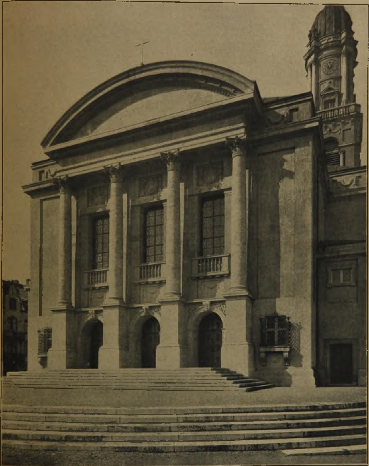
Abbildung 4. Hauptansicht nach dem Hohenzollernplatz.
