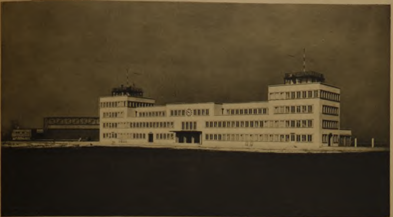
Ansicht der Südostseite
