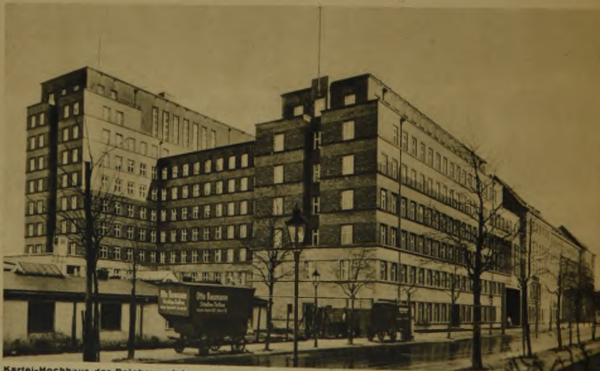
Kartel-Hochhaus der Reichsversicherungsanstalt für Angestellte in Berlin Architekten: Regierungsbaumeister Reuter, Braun u. Gunzenhauser, BDA, Berlin Zweck des Baues: Aufbewahrung für 20 Millionen Karten, außerdem Ärzte- und Röntgenräume Konstruktion: Stahlskelettbau mit Klinkerverkleidung; Erdgeschoß und I. Stock: Travertinverkleidung Bausumme: RM 3 000 000. Umbauter Raum: 70 000 cbm. Höhe des Baues: 37 m, 10 Geschosse
