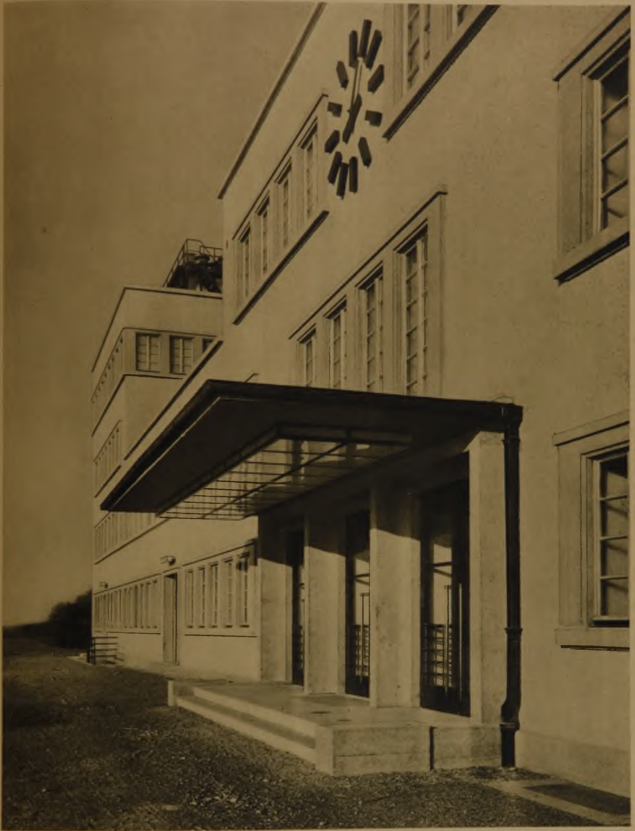
Verwaltungsgebäude Haupteingang, Schrägaufnahme
