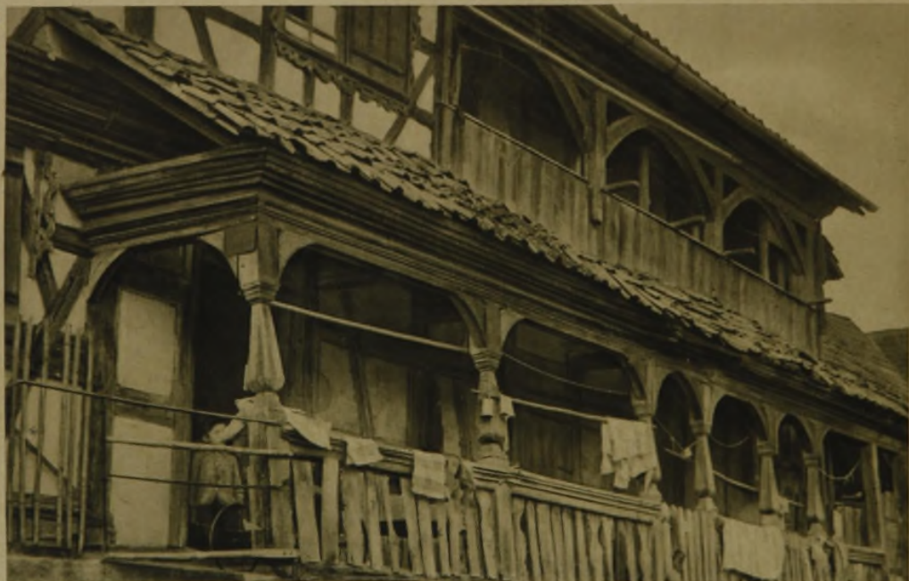
SÜDTHÜRINGISCHES BAUERNHAUS. ÜBER- DACHTE TREPPENLAUBE (PORLEM-VORLAUBE) AUF GESCHNITZTEN HOLZSÄULEN
