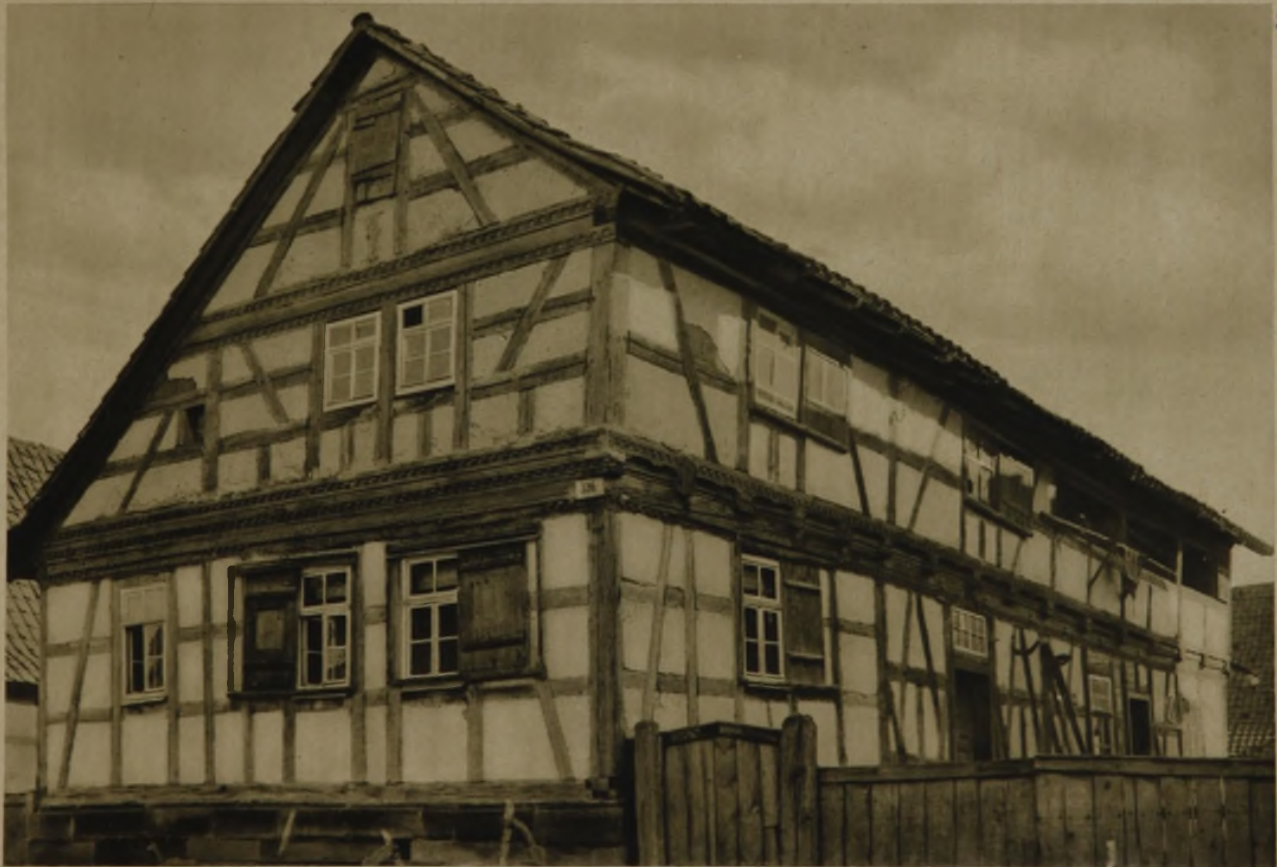
MILZ IN THÜRINGEN SÜDTHÜRINGISCHES BAUERNHAUS MIT EINHÜFTIGEM DACH (PFERDEKOPFDACH). OFFENER SEITENALTAN
