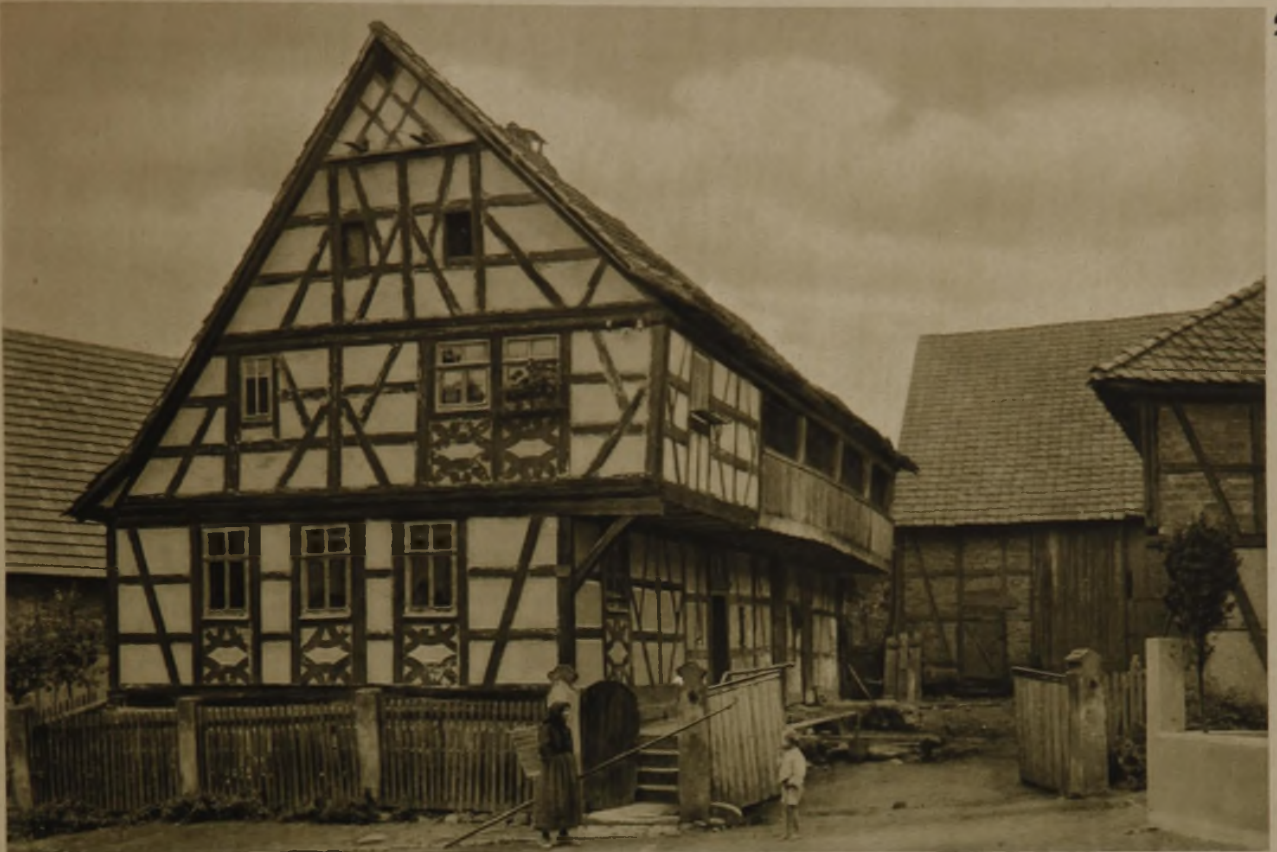
GLEICHAMBERG, KREIS HILDBURGHAUSEN SÜDTHÜRINGISCHES BAUERNHAUS MIT EINHÜFTIGEM ODER PFERDEKOPFDACH, BEDECKTEM GEHWEG AM HAUS ENTLANG, MIT GESCHOSSÜBERKRAGUNG UND OFFENEM SEITENALTAN
