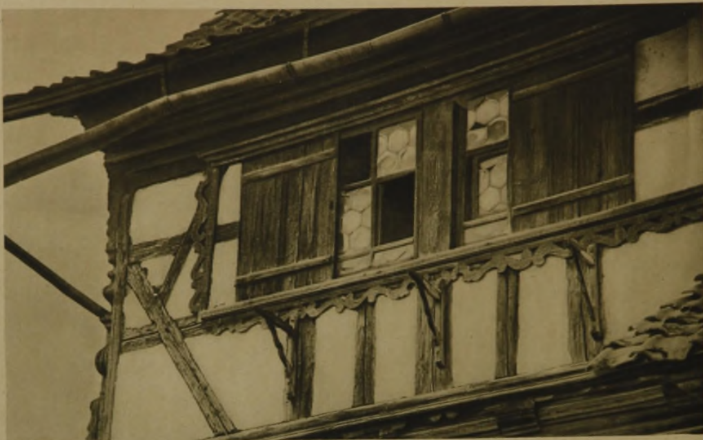
SÜDTHÜRINGISCHES SCHIEBEFENSTER MIT SCHIEBELÄDEN IN KUNSTVOLL DURCHBROCHENEM SCHIEBERAHMEN. GESCHNITZTE ECKSÄULEN
