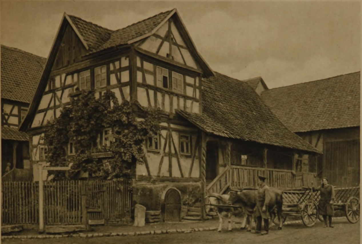
SIMMERSHAUSEN, KREIS HILDBURGHAUSEN SÜDTHÜRINGISCHES GEHÖFT. EINSTÖCKIGES BAUERNHAUS MIT GERADE AUSGEBAUTER GÄSTESTUBE IM DACHGESCHOSS VERMITTELS AUFBAU EINES ZWERCHHAUSES
