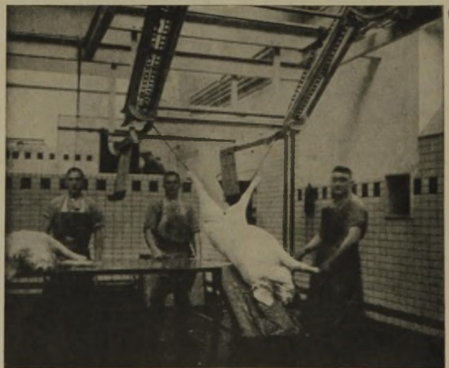
Elektrischer Elevator zum Verbringen der Schweine an die Förderbahn (Beck & Henkel)
