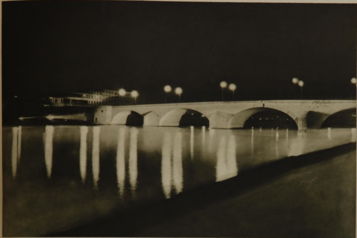
Neue „Alte Mainbrücke“ in Frankfurt a. M.
