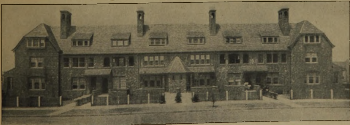
Abb. 18 bis 24. Reihenhäuser. Architekt G. Atterbury. Wohnhaustypen aus Forest Hills Gardens bei New York.
