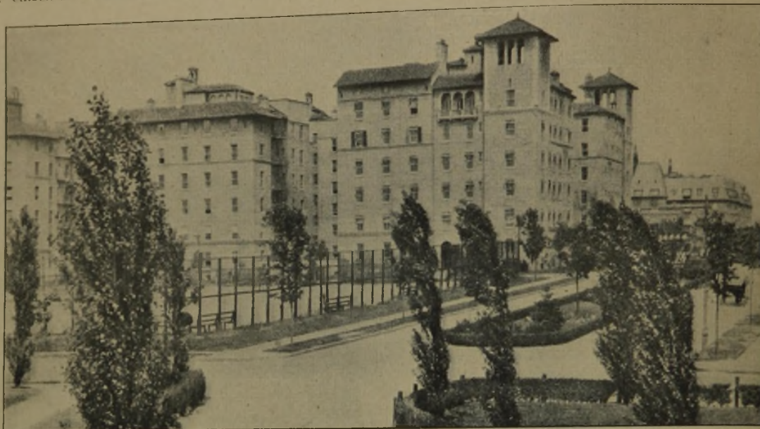
Abb. 3. Gebäude Gruppe „The Towers“ in Jackson Heights. New York.
