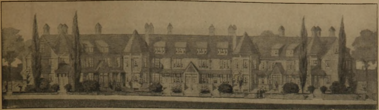
Abb. 16 und 17. Gruppenbau von Architekt G. Atterbury.
