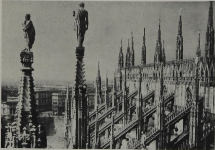
Das späte System der Streben, die sog. Eselsbrücken, die den Gewölbeschub aufnehmen. Viele Fialen und Figurentürmchen.
