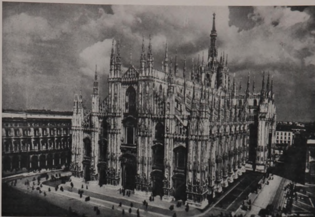
Die fünfschiffige Domkirche in lateinischer Gotik, 1. Baumeister Marco di Campione. Länge des Hauptschiffes 148 m außen, Stärke der Ringmauern 2,50 m.
