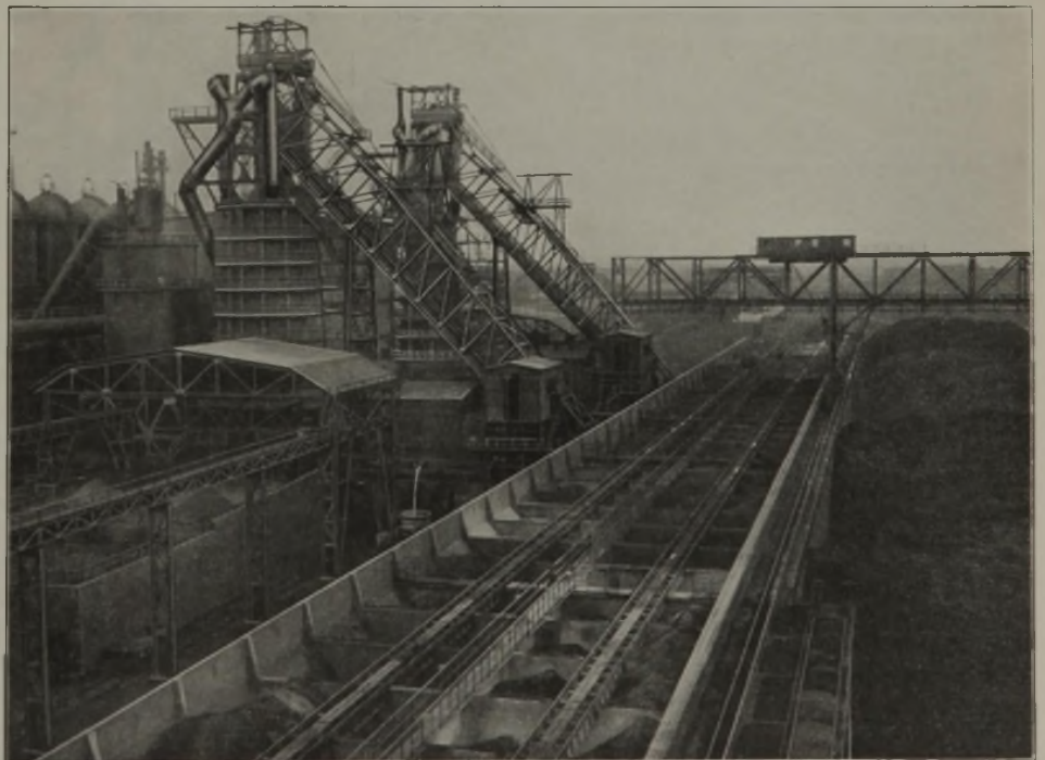
Abbildung 4. Hochöfen mit Bunkern.
