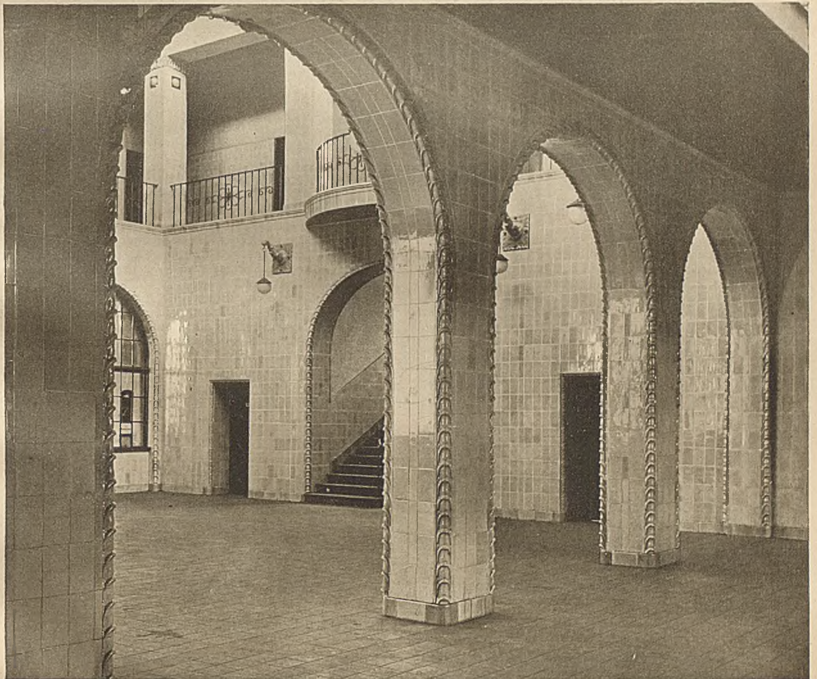
Arch. Reg.-Bmstr. Herm. Weigle - Stuttgart Schachtanlage Jacobi d. Gutehoffnungshütte b. Osterfeld i. W. Oben: Verwaltungsgeb. Unten: Lohnhalle i. Fa. Oberbaurat Weigle & Söhne - Stuttgart
