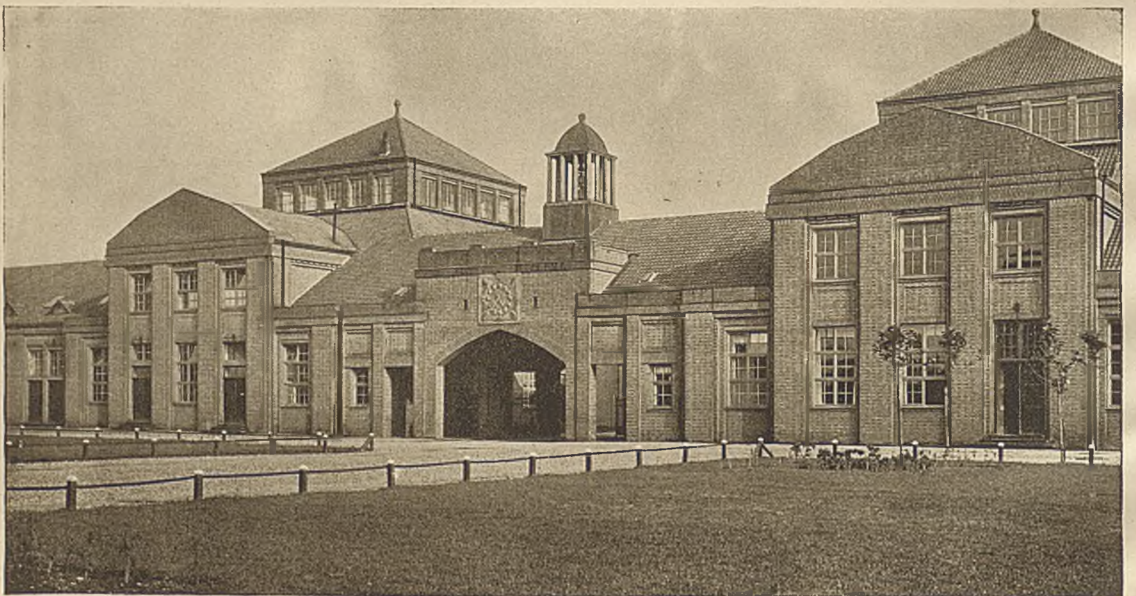
* Schachanlage Jacobi der Gutehoffnungshütte b. Osterfeld i. W. — Verwaltungsgebäude mit Haupteingang
