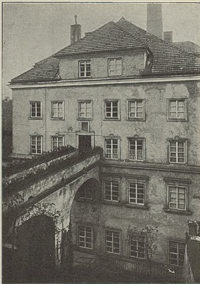
WIDOK DOMU A OD STRONY UL. BRZOSOWEJ
