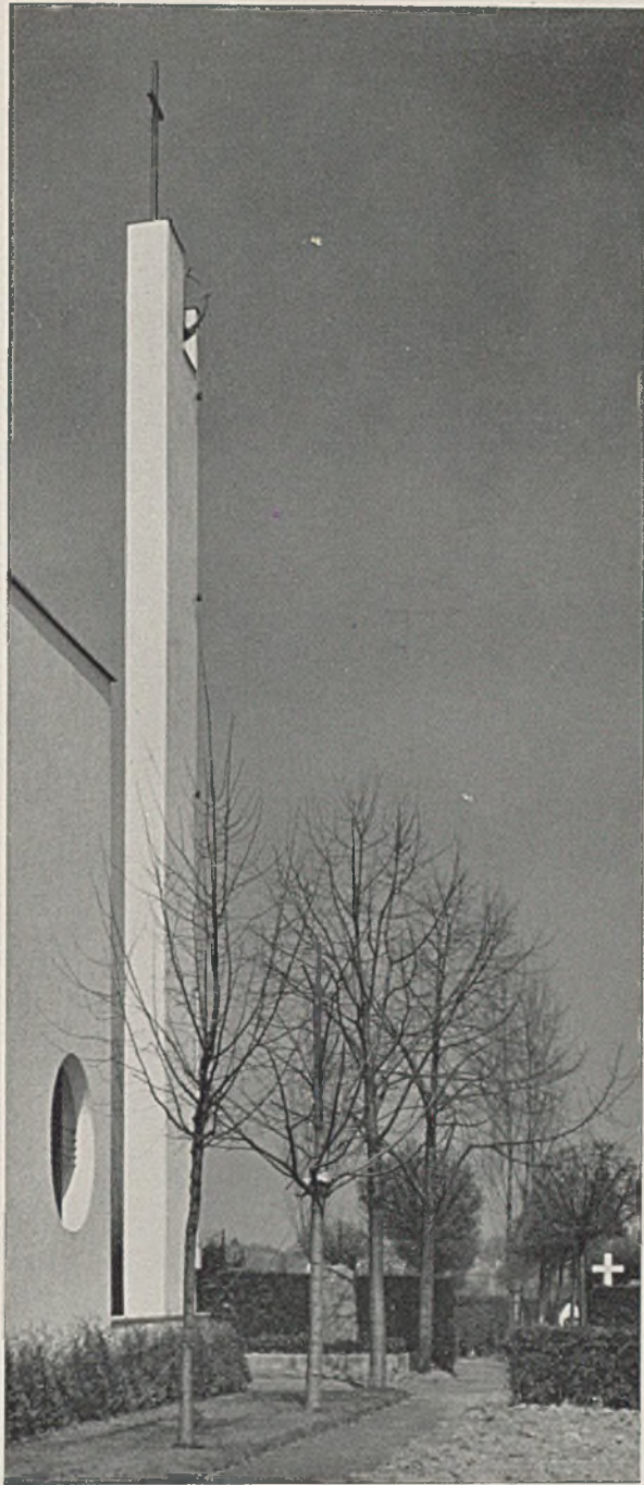
Campanile der Friedhofskapelle Stuttgart-Kornwestheim
