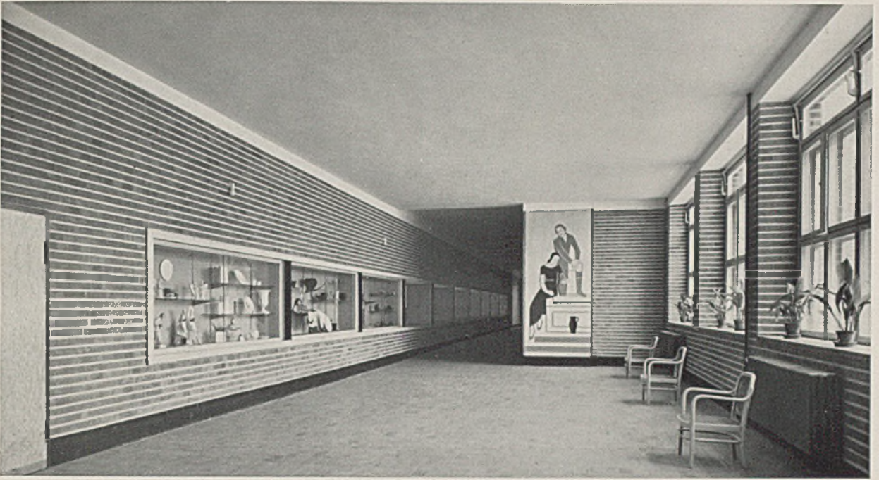
Halle im Erdgeschoß. Als Ziegelsteinwand ausgebildet wegen starker Beanspruchung (Abnutzung). Eingebaute Vitrinen für Kunstgewerbe und andere wechselnde Schaustücke
