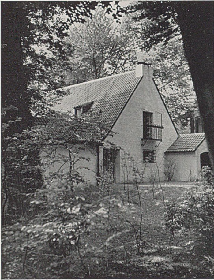
Einfamilienhaus Schmitz-Egelhoff; Straßenfront
