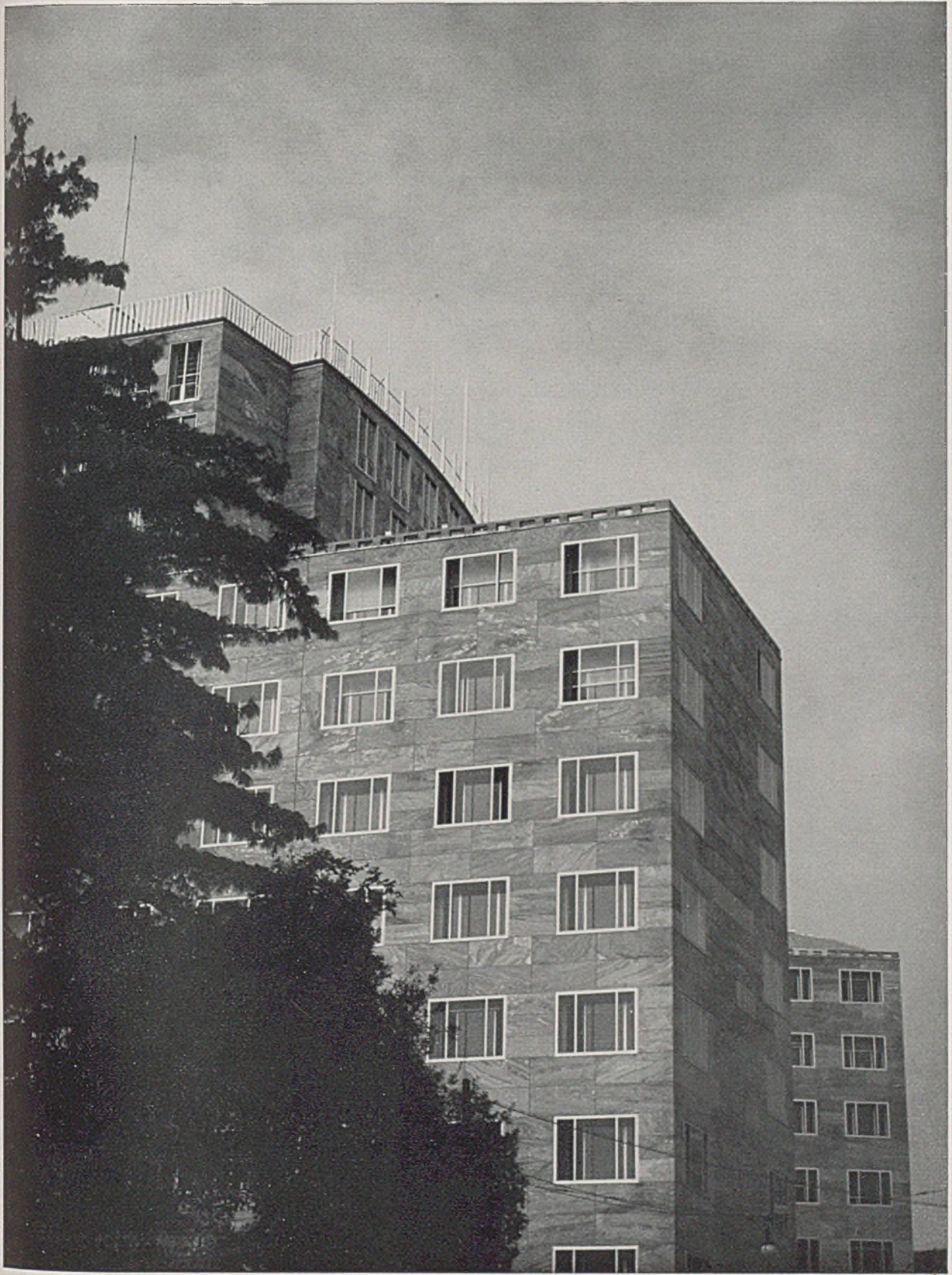
Blick aus der Via Moscova auf das Verwaltungsgebäude
