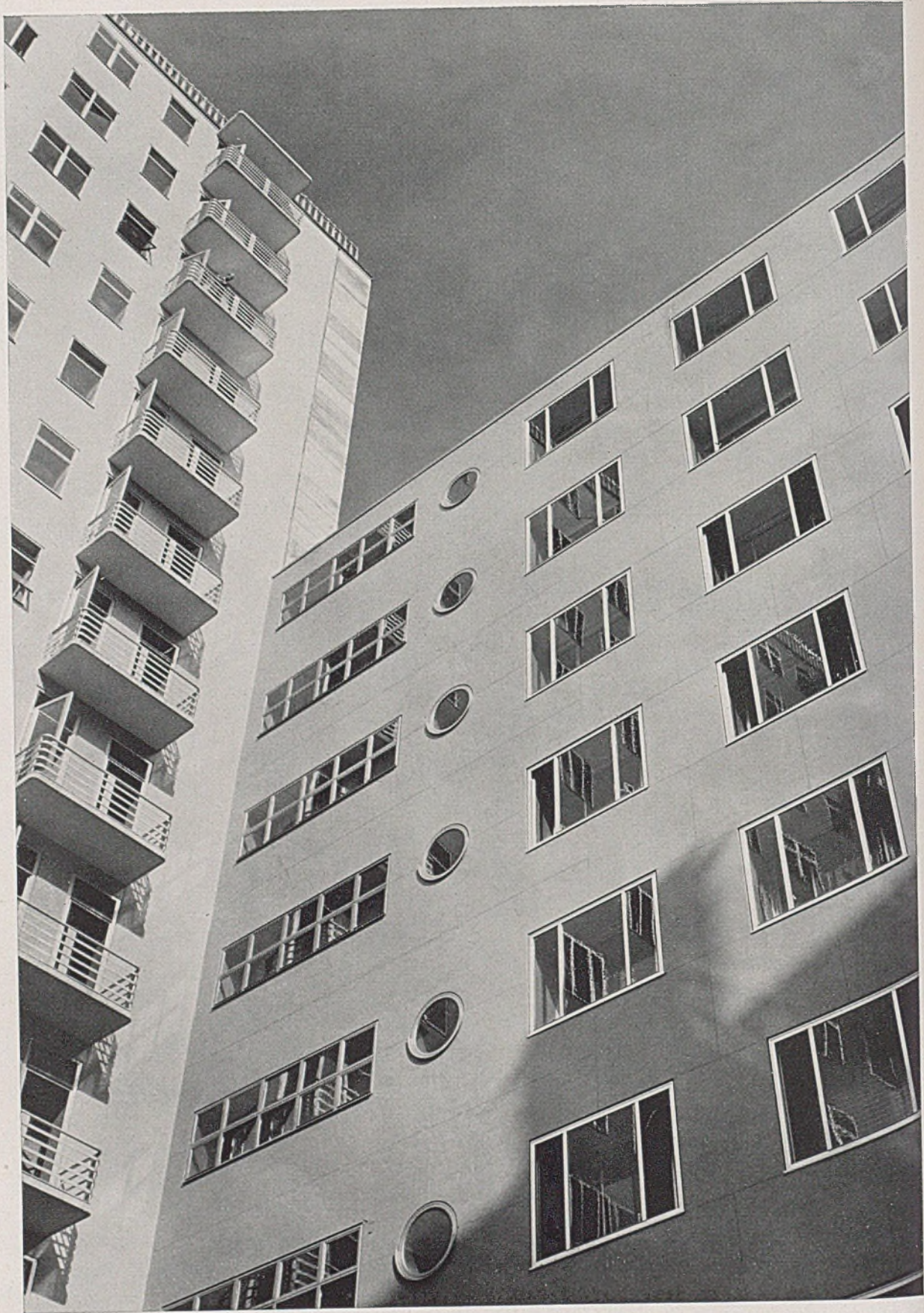
Anschluß eines Seitenflügels an den Mittelbau; hinter der Hauskante treffen Putz- und Steinfassade zusammen
