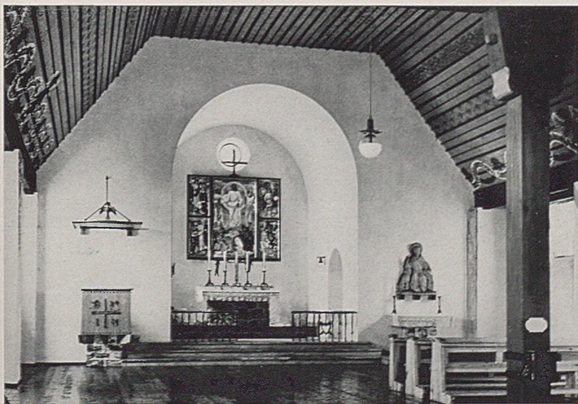
Blick auf Holzdecke (lasierend gefaßt), Altarraum und Predigtkanzel; Wände des Kirchenraumes verputzt
