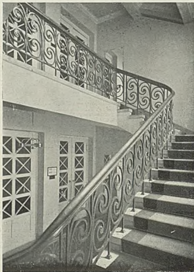
Rys. 16. Klatka schodowa w „Polonji”.
