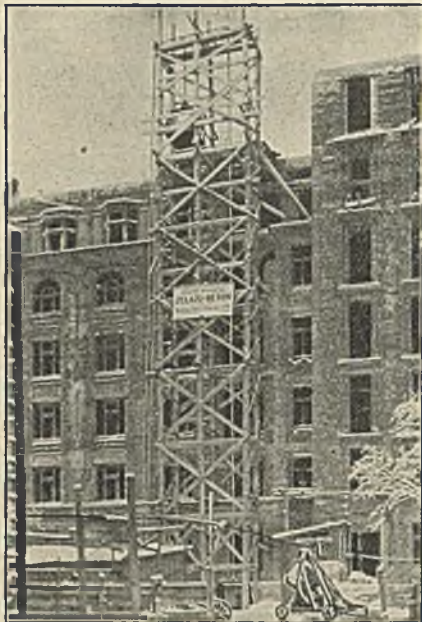
Budowa gmachu Spółdzielni w Warszawie w Al. Ujazdowskich № 9.
