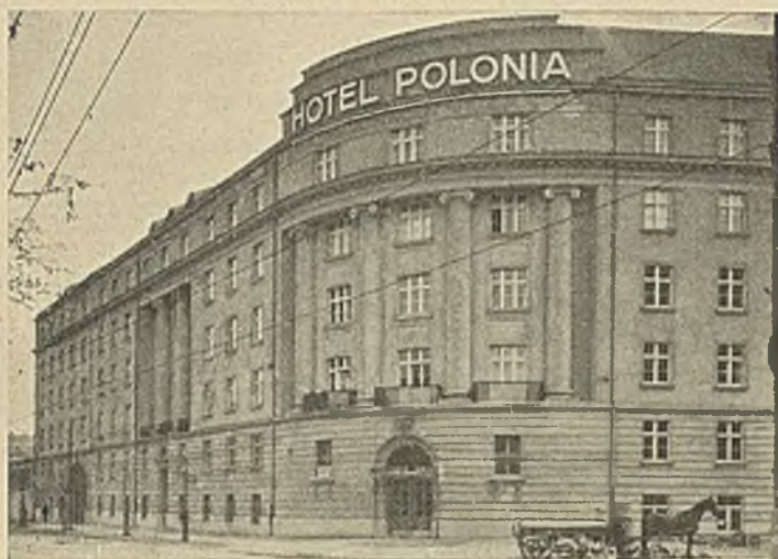
Hotel Polonia na Powsz. Wyst. Kr. w Poznaniu. Architekci: K. Ruciński i J. Tuszowski. Wyprawa elewacji szlachetną zaprawą „Terrazyt”.
