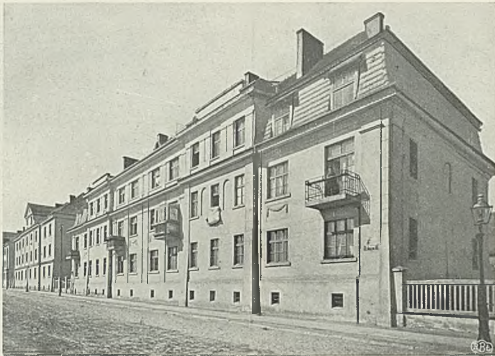
Rys. 47. Miejski Urząd Bud. Naz. w Poznaniu. Arch.: K. Ruciński i Stanisław Fertner (Poznań). Piąty dom z kolonji mieszkaniowej przy ul. Wspólnej w Poznaniu.
