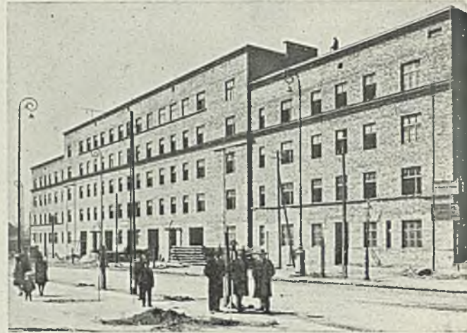
Blok I od ul. Łazarskiej.
