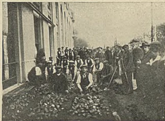
Wykonywanie prac brukarskich na ul. Marszałka Focha w Poznaniu.
