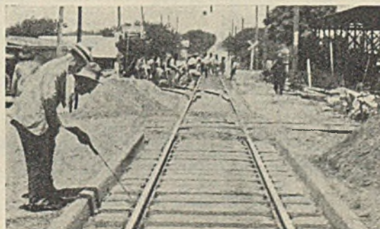
Abb. 1. Straßenbahngleis mit Betonschwellen.
