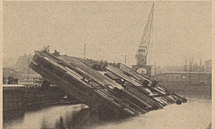
Abb. 6. Ausdocken eines Schwimmkranpontons in Schrägstellung.
