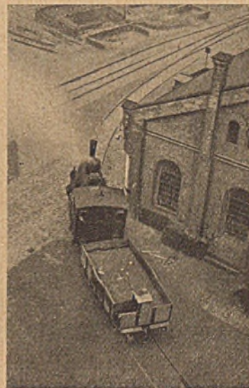
Abb. 3. Regelspurige Gleiskurve mit Spurkranzauflauf von 35 m Halbmesser.
