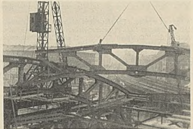
Abb. 23. Einbau eines oberen Querrahmens.
