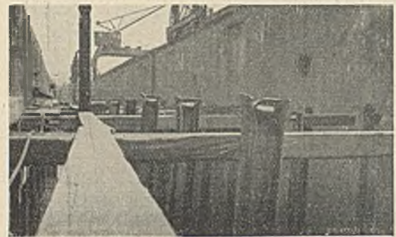
Abb. 10. Stahlpfähle Hafen I.
