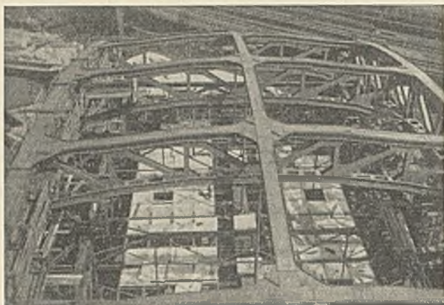
Abb. 26. Aufsicht auf den oberen Windverband (Rahmenverband).
