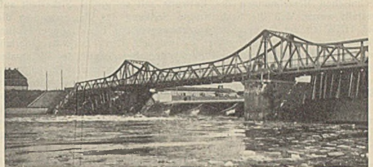
Abb. 4. Einlaßwehr zum Flutkanal.
