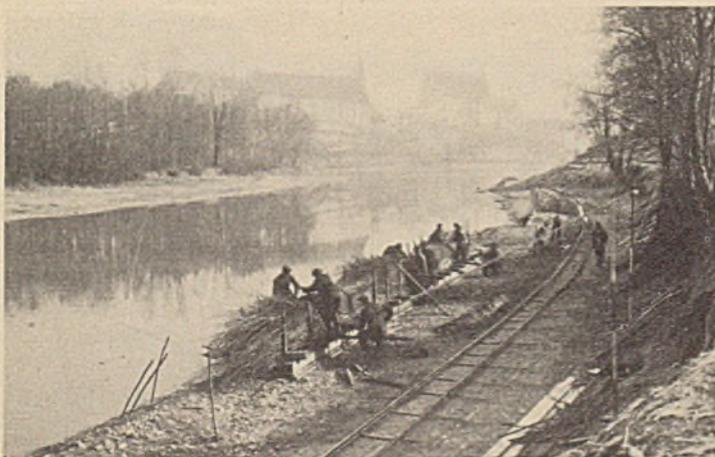
Abb. 52. Uferschutzbau bei Inn-km 158,0 oberhalb Wasserburg; Binden einer Faschinatwalze.
