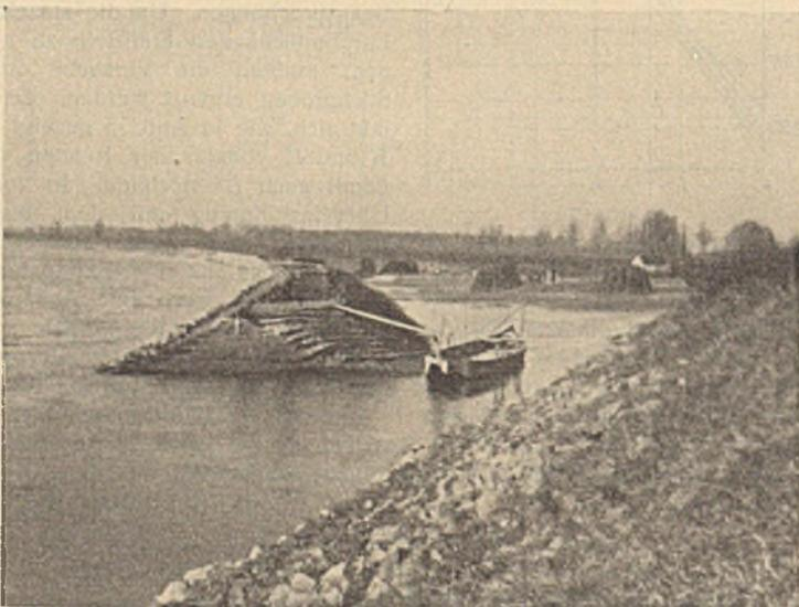
Abb. 57. Wie Abb. 56. Aufbringen des Kiesmaterials.
