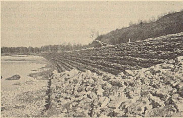
Abb. 54. Leitwerkbau zwischen Inn-km 125,3 und 125,5.
