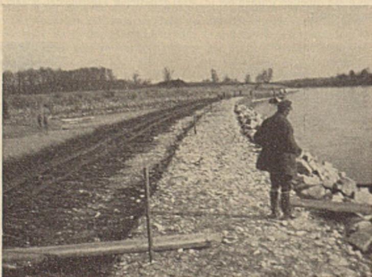
Abb. 56. Erhöhen des linkseitigen Leitwerks zwischen Inn-km 93,7 und 93,5.
