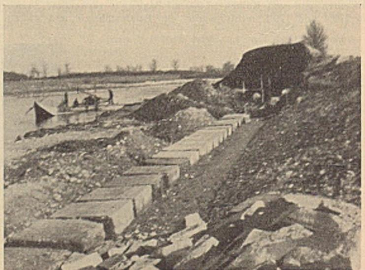
Abb. 58. Wie Abb. 56. Einbringen der Faschinlagen am unteren Bauende.
