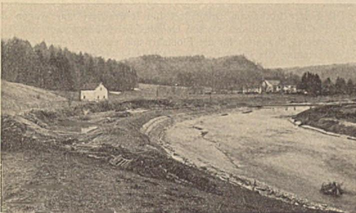
Abb. 67. Uferregulierung und Kurvenverflachung an der Mangfall bei Niederaltenburg; Blick flußaufwärts.
