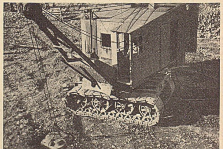
Abb. 85. Erste Bodenramme von Menck & Hambrock zum Abrammen der Schotter- und trockener Lehmschüttung.
