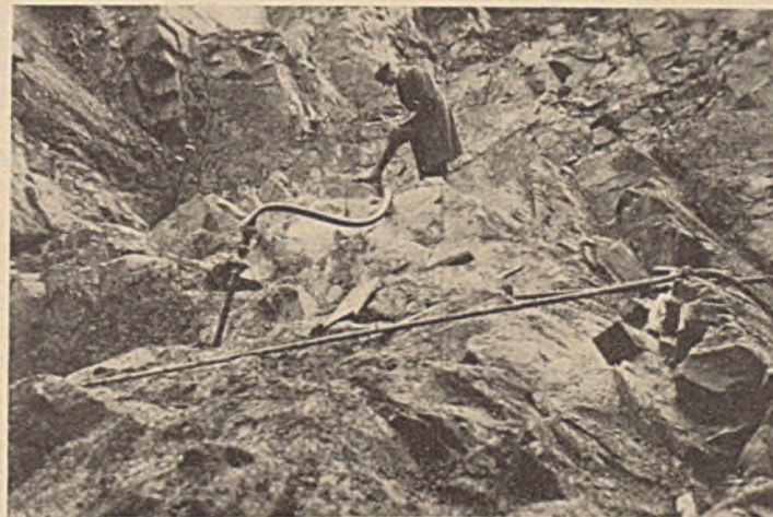
Abb. 41. Baugrube des Betonkerns der Sösetalsperre am linken Hang; Einspritzungen von Zement in die Grauwacke.
