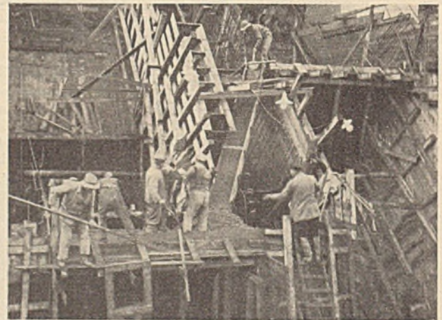
Abb. 93. Odertalsperre. Fertigstellung der Einläufe der Abb. 92 in den Betriebszustand. Verteilung des Betons durch Rutschen.
