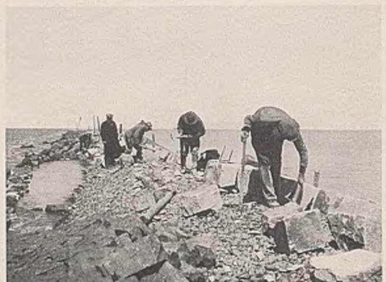
Abb. 20. Pflasterarbeiten auf dem Leitdamm.
