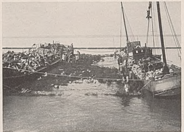
Abb. 13. Versenken des Sinkstückes.
