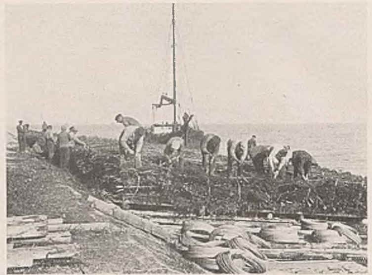
Abb. 11. Sinkstückbindestelle.
