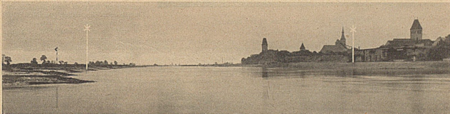
Abb. 1. Brückenbaustelle und Stadtbild.
