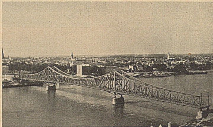
Abb. 8. Brücke über die Donau bei Novi-Sad.
