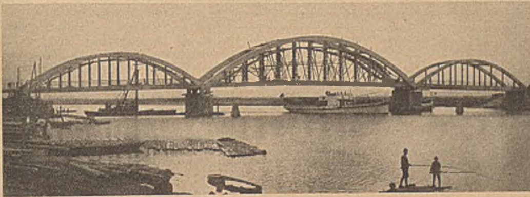
Abb. 2. Die Brücke fast vollendet.
