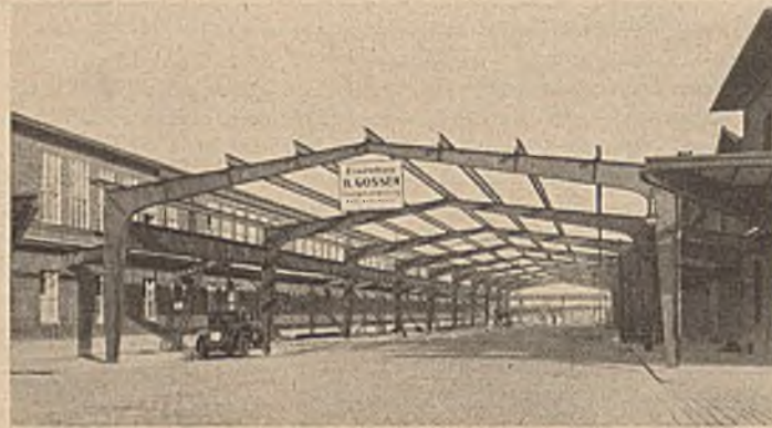
Abb. 5. Hofüberdachung der 3. Fleischgroßmarkthalle.
