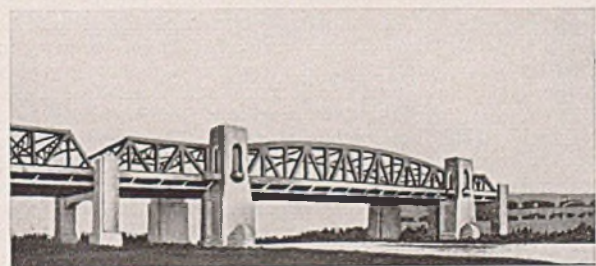
Abb. 3. Brücke über den Bronx-Kills. (Links anschließend Fachwerkbrücken über die Gleisanlagen in Bronx, rechts Abzweigbauwerk auf Randalls Island.)
