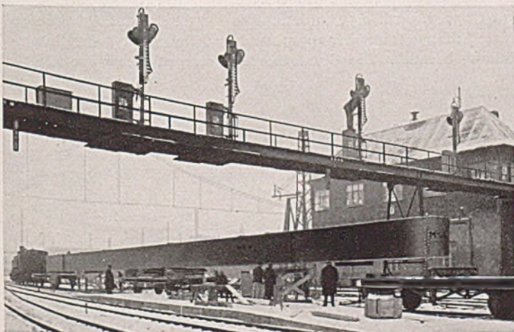
Abb. 4. Signalsteg I westlich in Nürnberg Hbf. Anlieferung des ersten Hauptträgerteiles.
