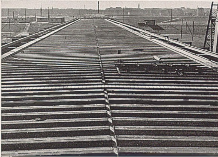
Abb. 1. Fahrbahnabdeckung der Flutöffnungen der „Admiral Graf Spee-Brücke“ über den Rhein bei Duisburg.
