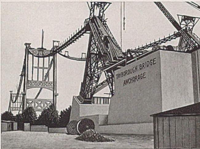
Abb. 16. East-River-Hängebrücke nach Beendigung der Kabelspinnarbeiten.
