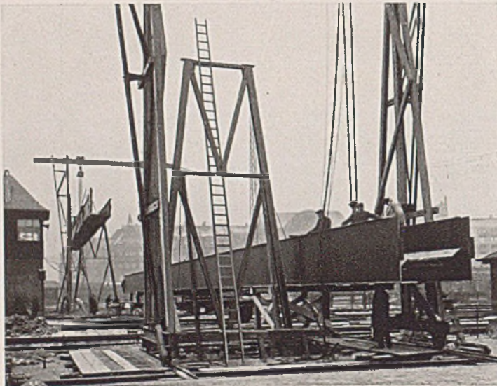
Abb. 7. Signalsteg I westlich in Nürnberg Hbf. Mittlerer Hauptträgerteil zum Anheben bereit.
