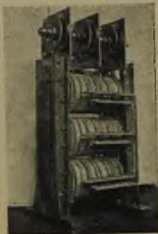
Transformator suchy 3-fazowy 40 kVA, dla pieca hartown.
