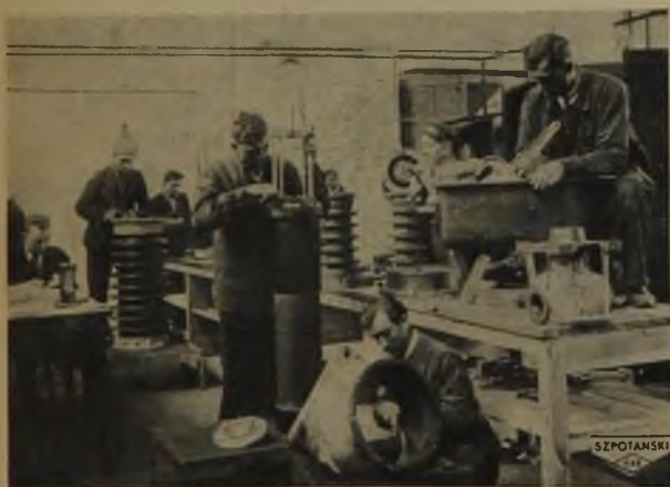
Fot. 4. Montaż części aktywnej wyłącznika 150 000 V
