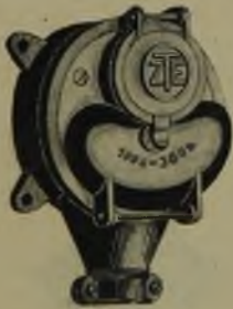
Rys. 22. Gniazdo wtykowe żeliwne, szczelne 100 A, dla instalacji kablowej. (Zjednoczone T-wo Elektr.).
