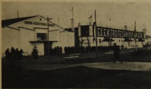
Rys. 3. Pawilony Elektrotechniki i Radiotechniki.
