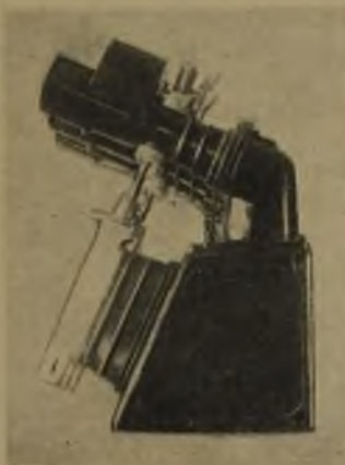
Rys. 3. Wyłącznik powietrzny bezsprężarkowy, bezolejowy, 20 kV, 500 A, 200 MVA (K. Szpotański i S-ka).
