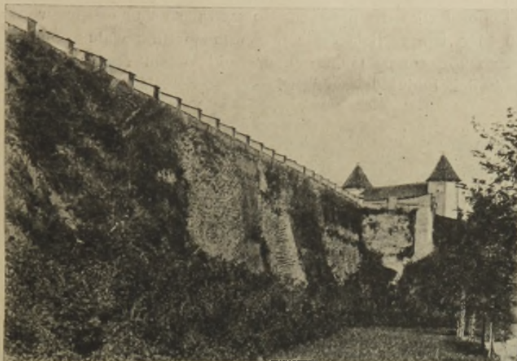
Fig. 4. Ołyka. Mur obwodowy wałów północno-wschodniej strony twierdzy, i bastion północny (z fotogr.).
