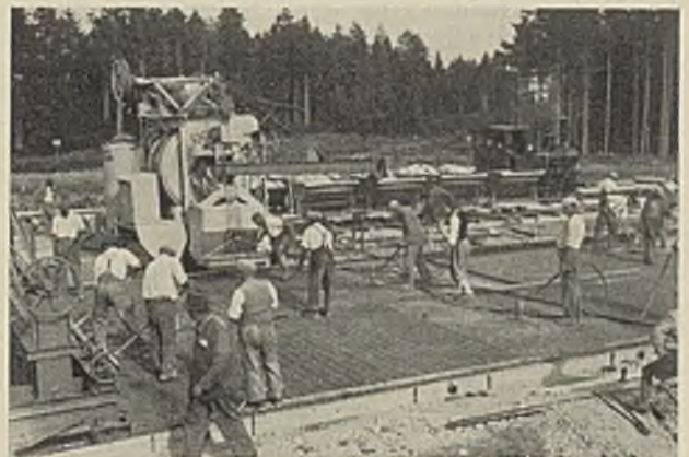
Abb. 2. Das Einlegen der Baustahlgewebe zwischen den beiden Betonschichten.
