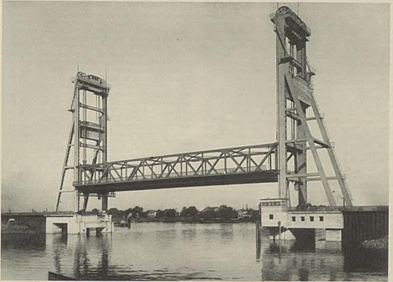
Oben: Hubbrücke vom Wasser gesehen.
