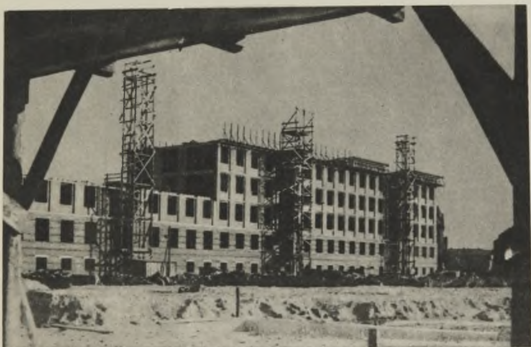
BUDOWA GMACHU WYDZIAŁU GÓRNICZEGO
