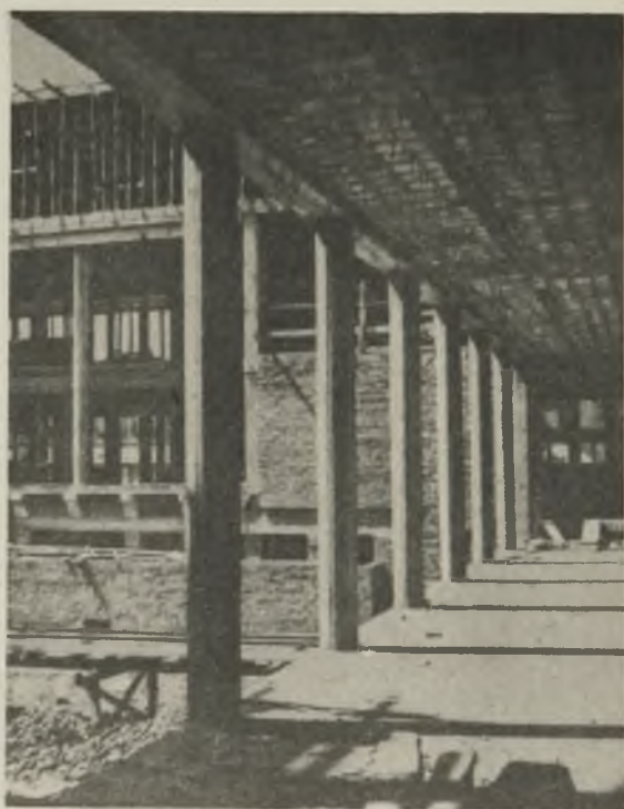
BUDOWA GMACHU WYDZ. INŻYNIERYJNO-BUDOWLANEGO
