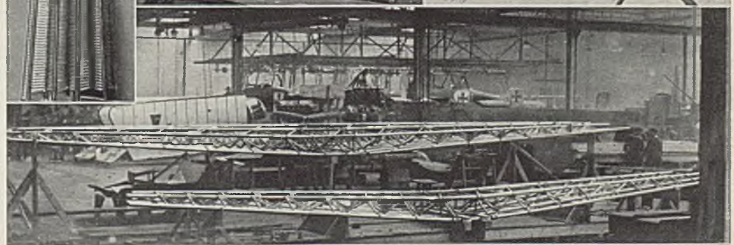
Der durchgehende Junkers-Tiefdecker-Flügel.
