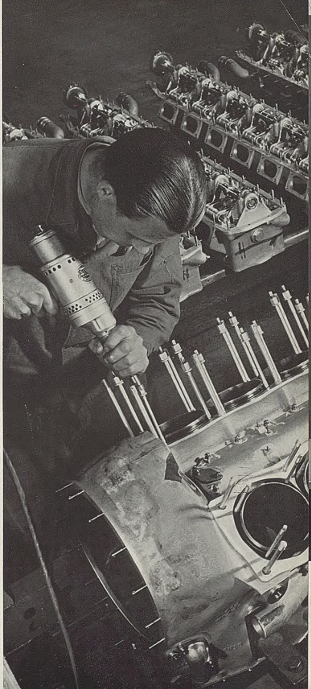
Zusammenbau des Junkers-Benzin- Flugmotors JUMO 211.
