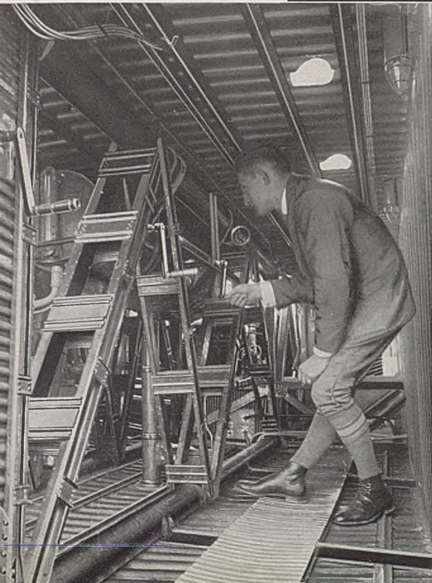
Das Innere eines G 38-Flügels. Durch seine Dicke sind alle vier Motoren leicht erreichbar und im Fluge wartbar.
