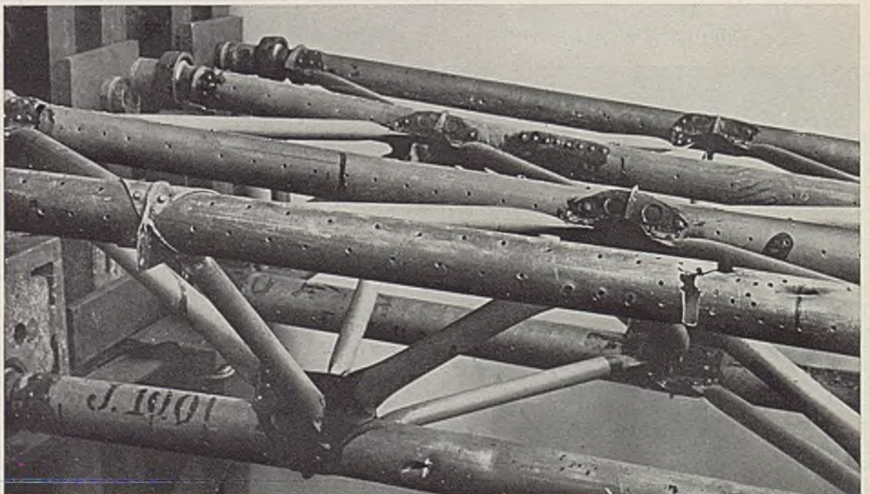
Festigkeitsprüfung eines Flügels der J 4, der starke Schußverletzungen aufweist.
