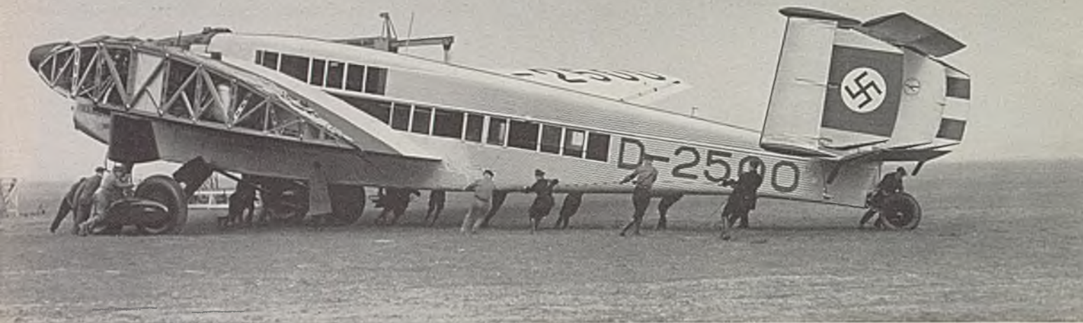
Junkers-G 38, viermotoriges Personen- und Frachtverkehrsflugzeug, das größte Landflugzeug seiner Zeit, an dem erstmalig der Gedanke des Nur-Flügel-Flugzeuges teilweise verwirklicht wurde (1929/30). Der linke Flügel ist demontiert. Man beachte die Dicke des Flügelprofils im Verhältnis zu den Personen auf dem Bilde.
