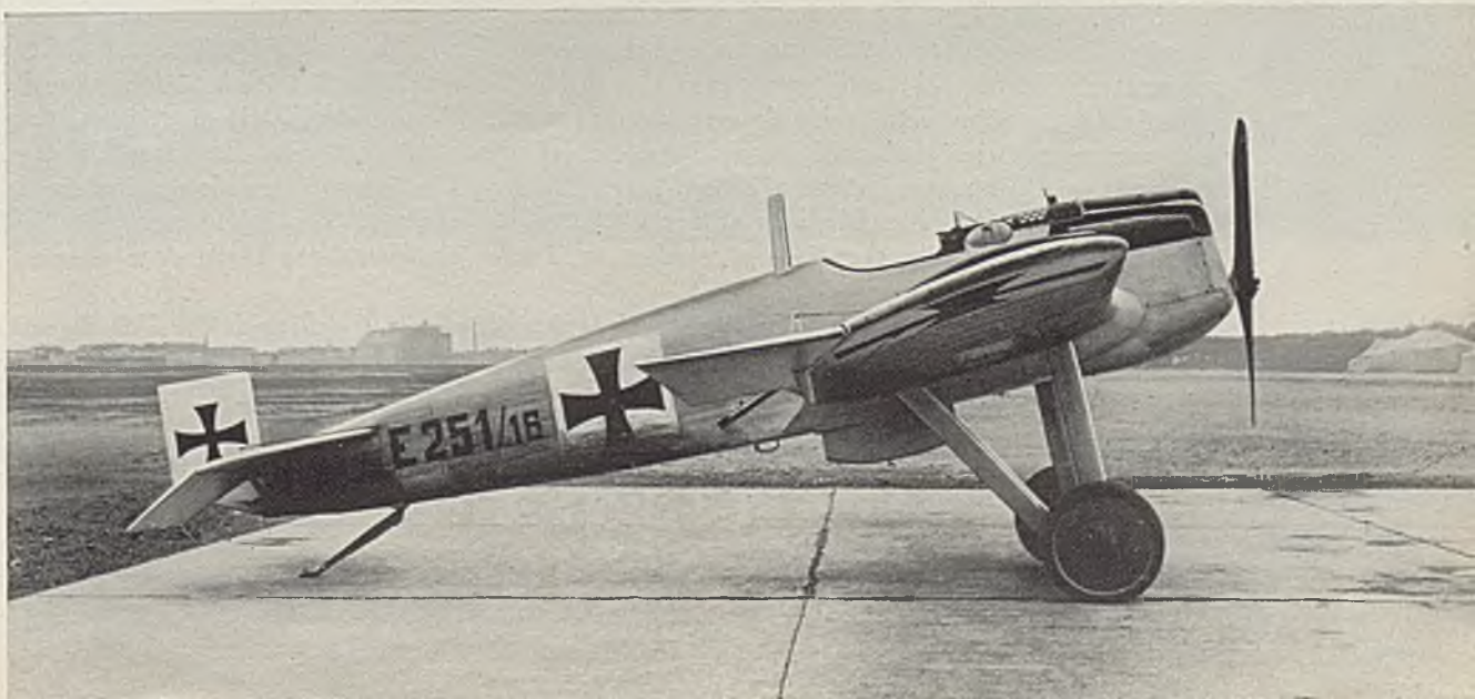
Erster freitragender Ganzmetall-Tiefdecker in Glattblechbauart, Junkers-J2, eine Weiterentwicklung der J 1, flugklar zur Front.
