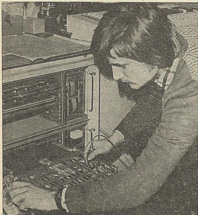
Marek Leszczyński dba o sprawność minikomputerów. Naprawa pakietu komputera MERA 303 nie sprawia mu wiele kłopotu
