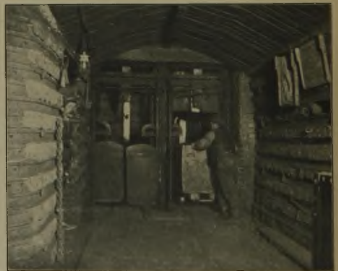
Fig. 7. Eisenpfeilerbeton mit Firstensparren. Füllort von Wilhelmschacht I.
