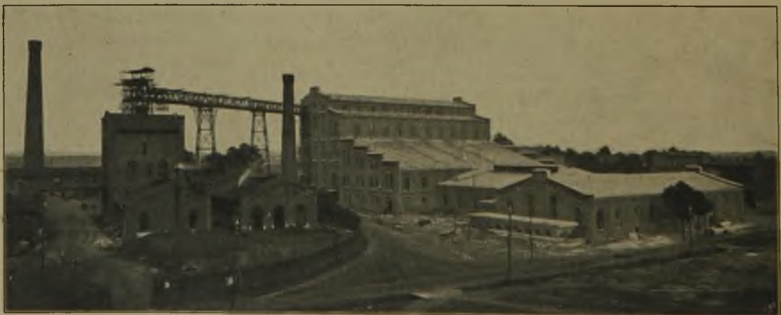
Fig. 1. Ansicht der neuen Blendeaufbereitungsanstalt.
