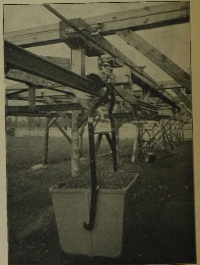
Fig. 6. Selbsttätige Weiche einer Elektrohängebahn.
