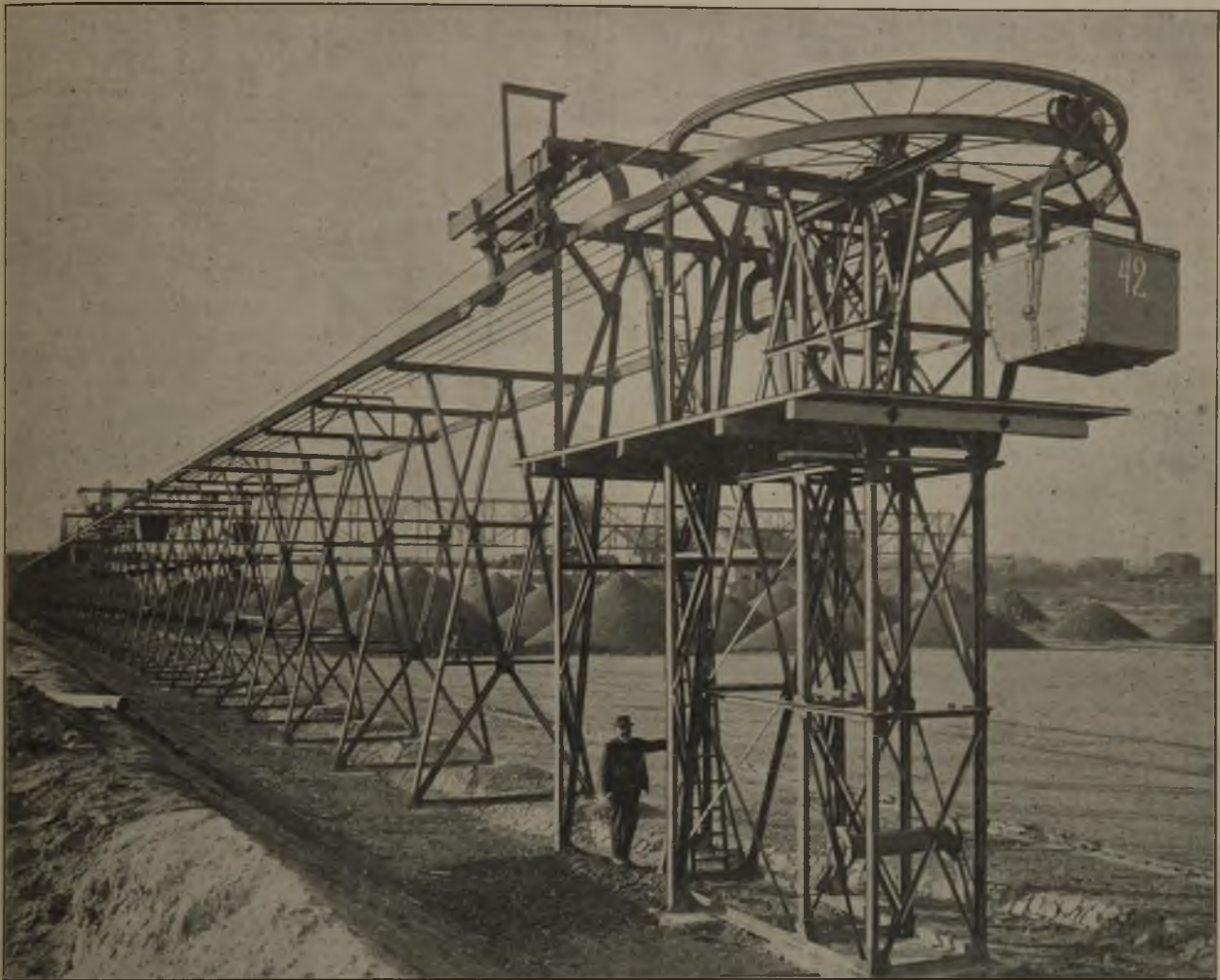
Fig. 3. Zubringerseilbahn der Haldenanlage auf dem Hillebrandtschacht.
