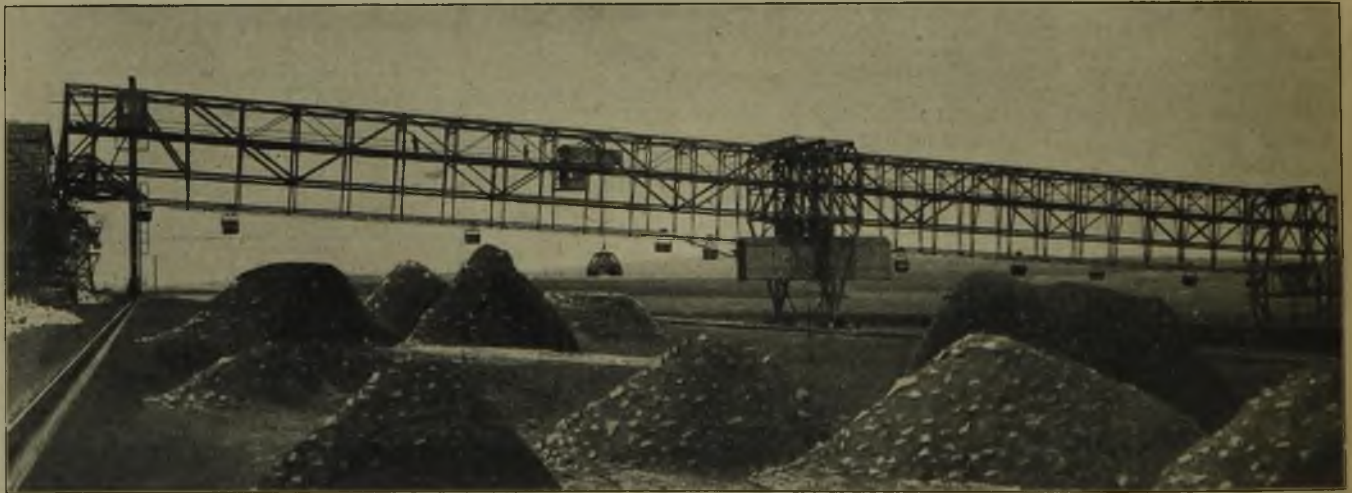
Fig. 4. Haldenanlage auf dem Menzelschacht (Bauart Riedel-Benrath).
