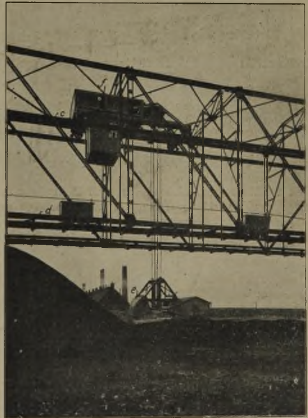
Fig. 6. Katze mit Greifer der fahrbaren Verladebrücke auf der Radzionkaugrube.
