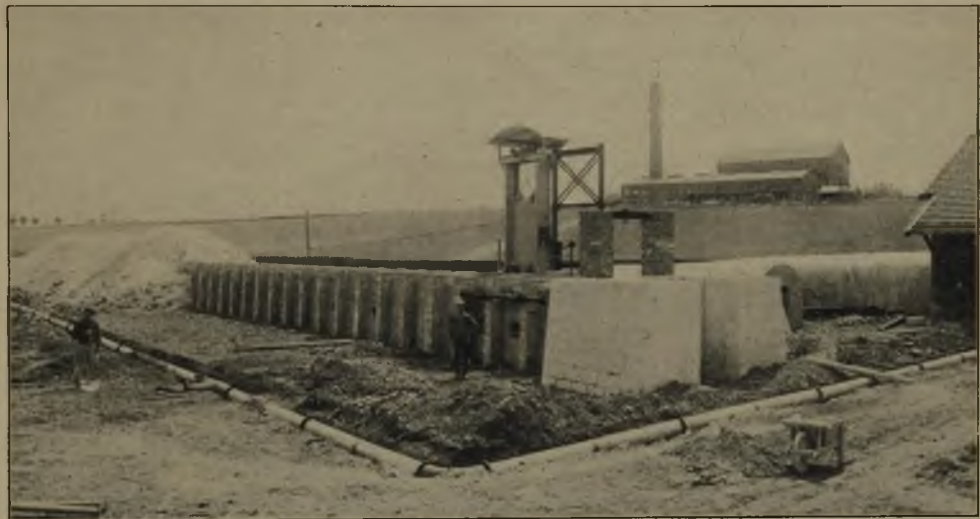
Fig. 2. Der gemauerte Teil der Versuchstrecke mit Ventilatorstrecke und Falltür.
