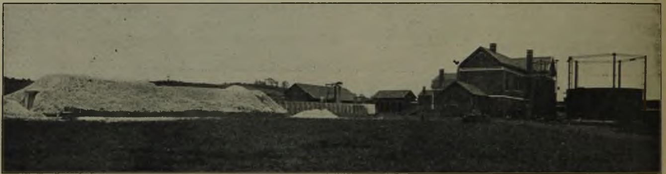
Fig. 3. Die Versuchstrecke unter Erdaufwurf; rechts Hauptgebäude und Gasometer.
