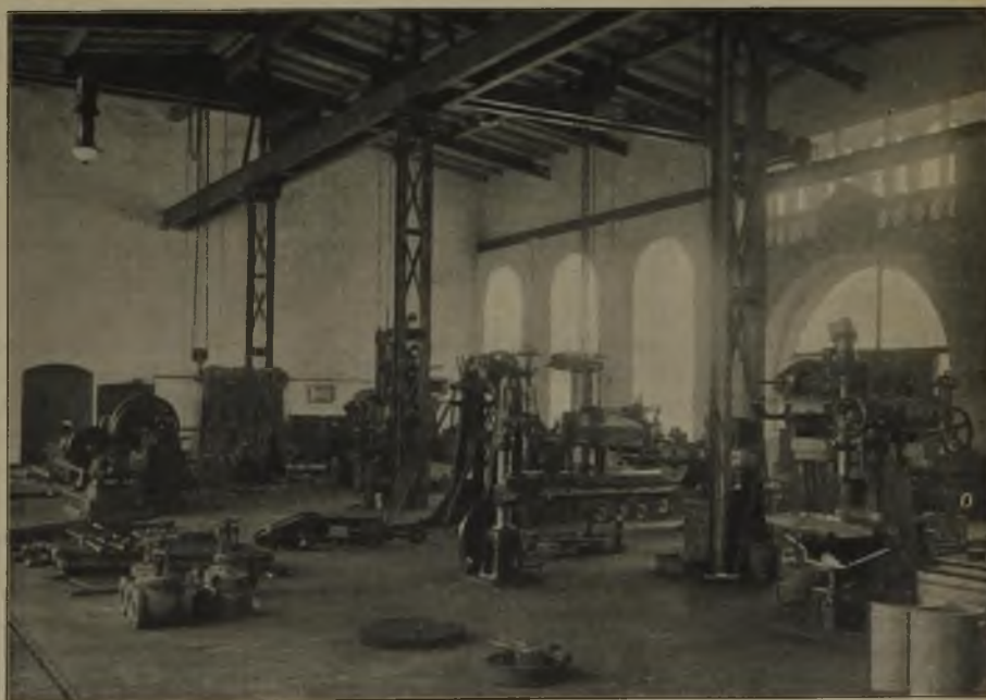
Fig. 4. Innenansicht der Schlosserwerkstatt.
