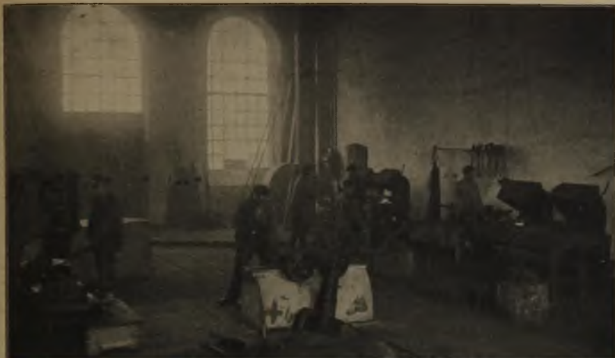
Fig. 3. Innenansicht der Schmiede.
