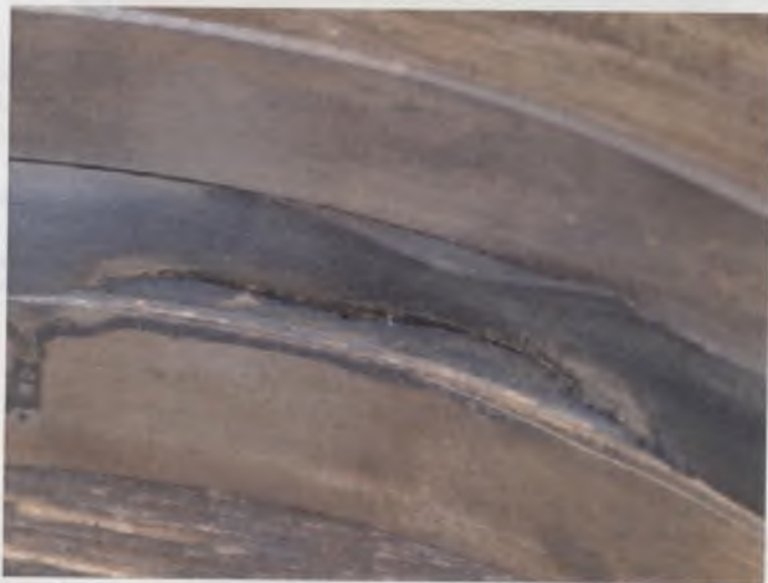
Rys. 9.10. Pierścień oporowy połączony warstwą elastomeru z pierścieniem stałym. Widać uszkodzenia gumy, przez którą przedarła się woda pod ciśnieniem ok. 5,5 MPa
