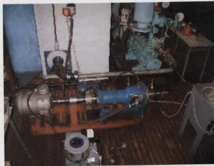
Rys. 4.12. Widok stanowiska badawczego w Laboratorium Maszyn Hydraulicznych Politechniki Śląskiej Fig. 4.12. View of the test stand in the Laboratory of Hydraulic Machines at the Technical University of Silesia
