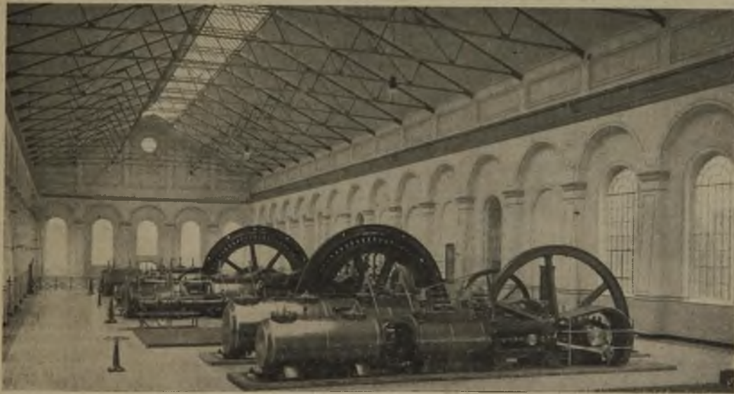
Fig. 13. Kompressor mit Antriebsmaschine.
