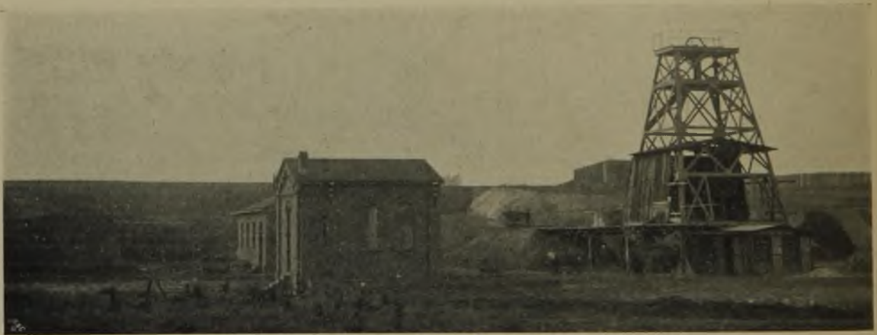
Fig. 10. Tagesanlagen auf Schacht 4.
