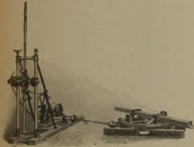
Fig. 6. Handbohrmaschine mit angebautem Pferdewagen der Sullivan Machinery Co. Chicago.
