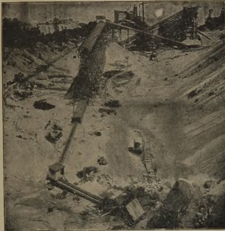
Fig. 48. Bewegung des von einer Dampfschaufel gelösten Gebirges durch einen Robins Gurtförderer.
