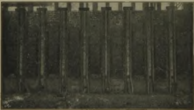
Fig. 1. Koksofenbatterie beim ersten Anheizen.
