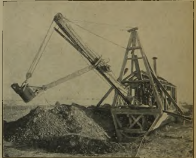
Fig. 47. Schiffstyp einer Dampfschaufel mit provisorischem Holzunterbau. Marion Steam Shovel Co., Marion, Ohio.
