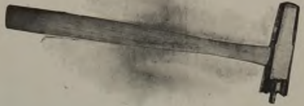
Fig. 81. Aufhauhammer mit Dorn für das Ausschmieden des Bohrmeißels von Ingersoll-Schlagbohrhämmer.
