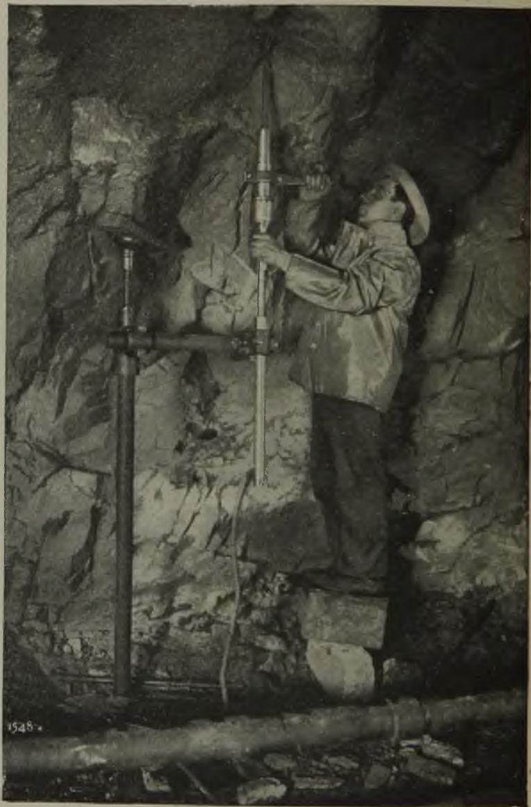
Fig. 71. Ingersoll-Bohrhammer am wagerechten Arm einer senkrechten Spannsäule.
