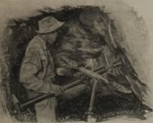
Fig. 72. Ingersoll-Hammer an leichter Spreize, und dem größern Übertragungsverluste der längern Bohrstangen, bei jeder Bohrerlochteufe dieselbe.
