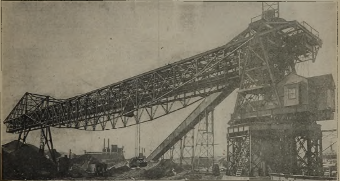
Fig. 118. Kohlenverladungsbrücke mit schwebender Gurtförderung. Kokerei Milwaukee der Semet-Solvay Werke, Syracuse, N. A.
