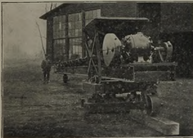
Fig. 114. Gurtförderer mit wagerechter Bahn auf dreiräderigem Fahrgestell.
