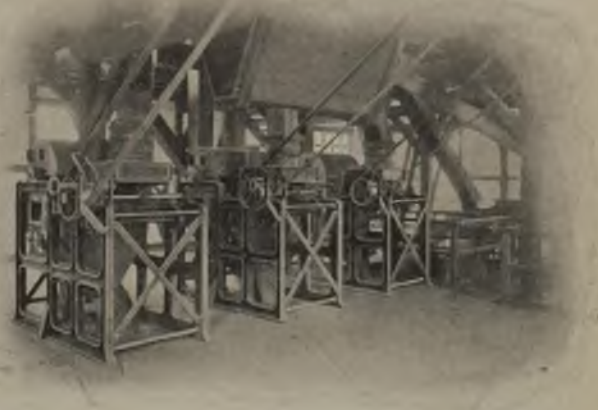
Fig. 4. Aufstellung der Separatoren in der Aufbereitung Brüderbund.
