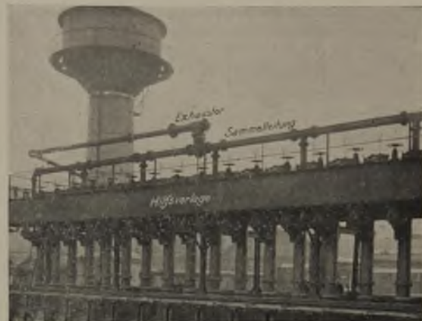
Fig. 2. Koksöfenbatterie mit der Absaugevorrichtung.
