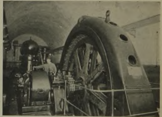
Fig. 3. Ansicht der Wasserhaltungsanlage.
