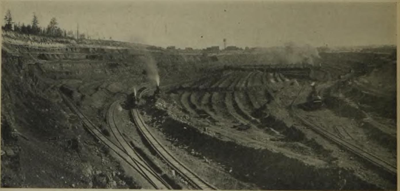
Fig. 166. Eisenerztagebau mit Dampfschaufelbetrieb.
