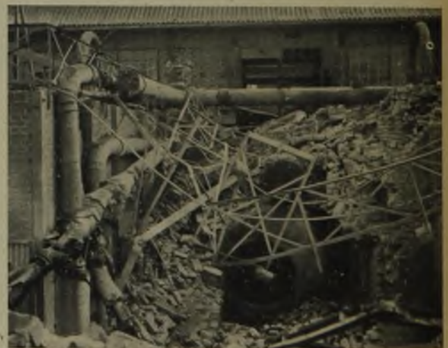
Fig. 5. Hintere Ansicht des zerstörten Kessels.
