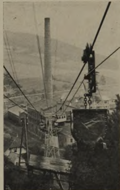
Fig. 1. Fabrik mit Entladestation.
